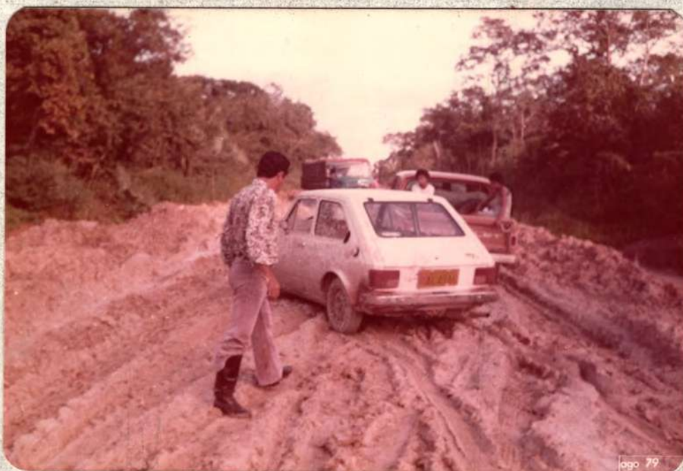
FOTO 02 - Outro aspecto da mesma rodovia
