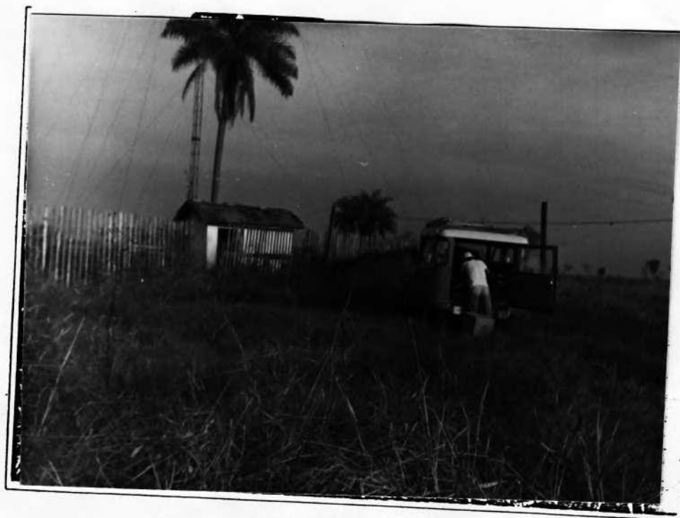
BARRA DO BUGRES = Rotina da equipe de manutenção.
